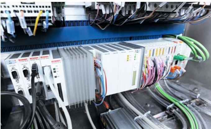
Ein Embedded-PC CX1030, TwinCAT NC PTP und die EtherCAT-Kommunikation sorgen bei den Handhabungsmodulen für schnelle und präzise Steuerungsabläufe.
