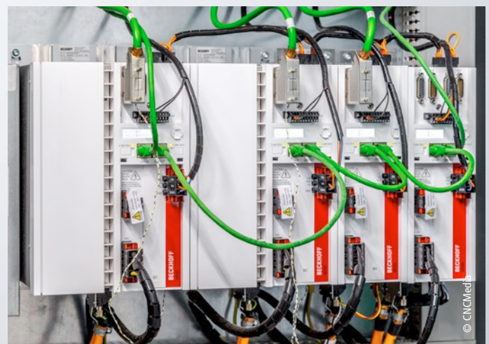
Die Servoverstärker AX5000 sorgen für dynamische und präzise Wellenbewegungen des Laser-Kopfes.
