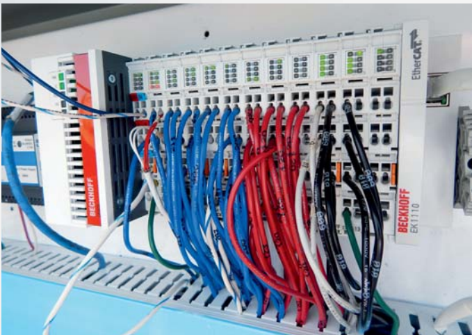
Der Embedded-PC CX5020 fungiert als zentraler Controller der Windkraftanlage; er übernimmt die Steuerung, die Netzverbindung, das Gieren und Positionieren, die Datenerfassung und das Versenden von Fehlermeldungen.
