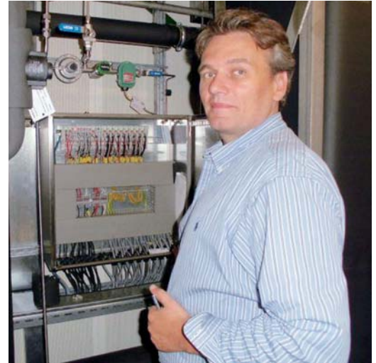
Mathieu de Bas, Projektleiter und Mitbegründer der Gastreatment Services, vor dem Schaltschrank der Grüngasanlage
