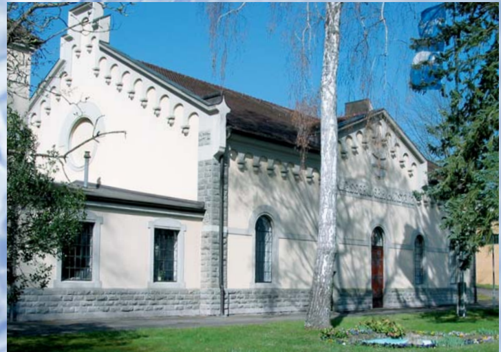
Das Wasserwerk Konstanz wurde mit der PC-basierten Steuerungstechnik von Beckhoff modernisiert. Diese ermöglicht einen höheren Bedienkomfort und eine bessere Versorgungssicherheit.
