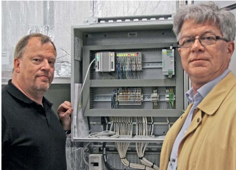
Widex-Projektleiter Allan Ebert Skotte (links), zuständig für alle technischen Gebäudeinstallationen, und Claus Clausen, Geschäftsführer von Beckhoff Dänemark
