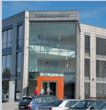
Das Beckhoff-Büro nahe dem Kai des Tønsberger Hafens
