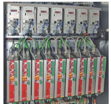
25 elektromotorische Servoachsen und zwölf hydraulische Servoachsen werden mit Beckhoff-Servoantriebssystemen des Typs AX2003 geregelt.
