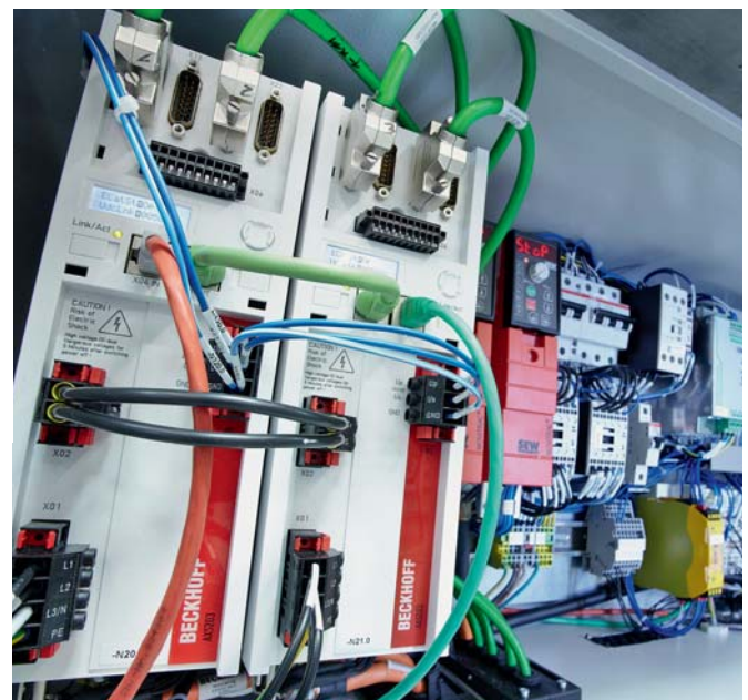
Blick in den Schaltschrank mit EtherCAT-Servoverstärker AX5000 und EtherCAT-Klemmen zur dynamischen und zuverlässigen Ansteuerung des Delta-Roboters.
